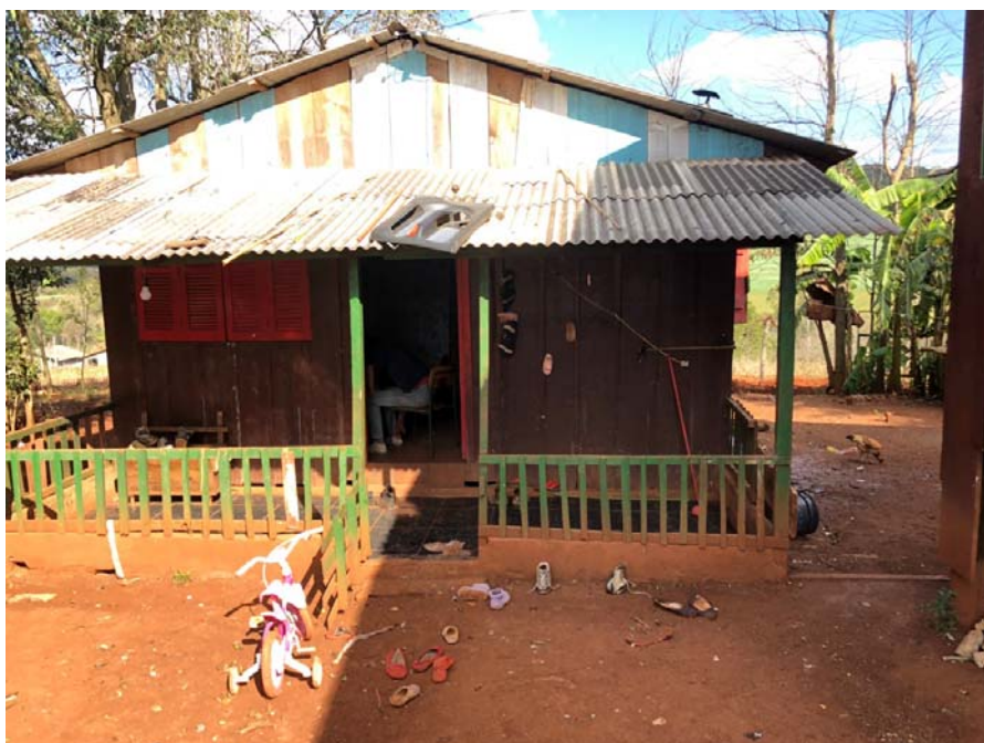
Foto 01: Rosimeri Ferreira Pedroso - Sem banheiro - Realizado teste de infiltração
