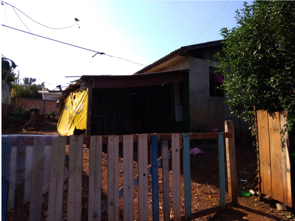
Foto 16: Clevi Bueno - Com banheiro - Tratamento de Esgoto
