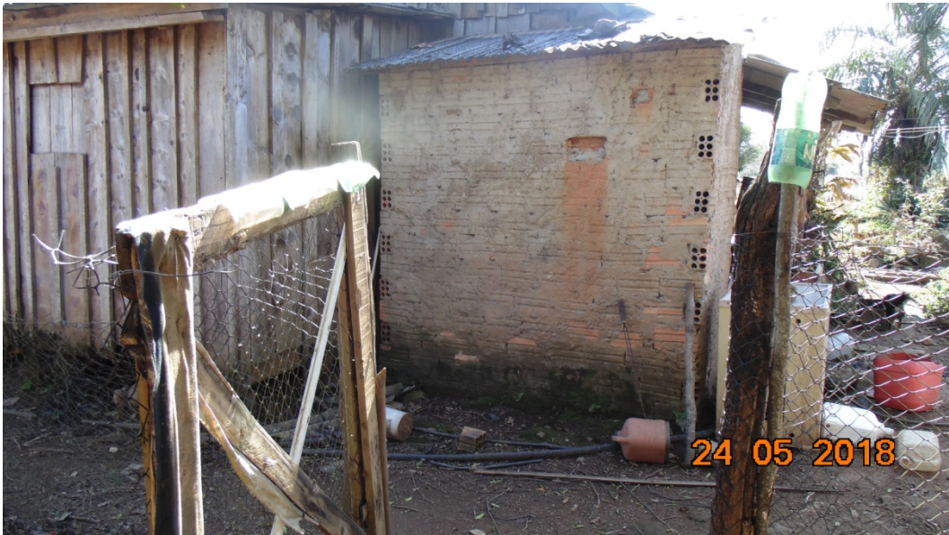
Foto 19: Artivina Lopes - Banheiro existente
