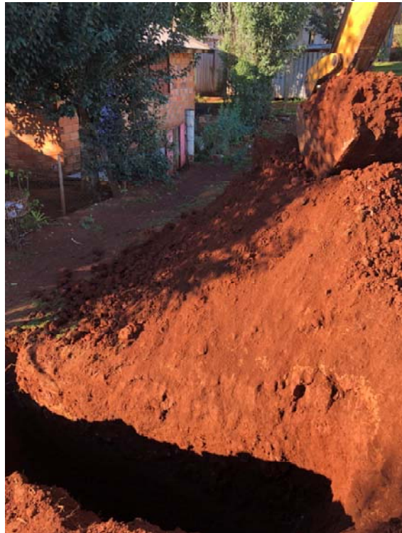
Foto 15: Marina Ferreira - Banheiro sem condições de uso - Investigação do Solo
