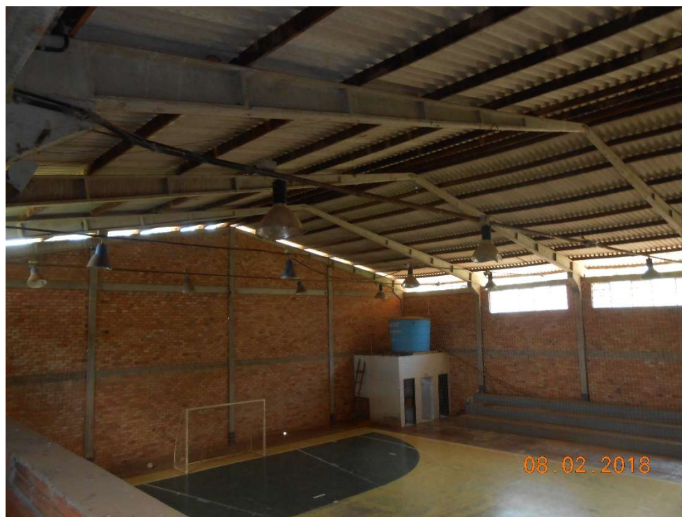
Figura 1 – Vista interna da edificação
