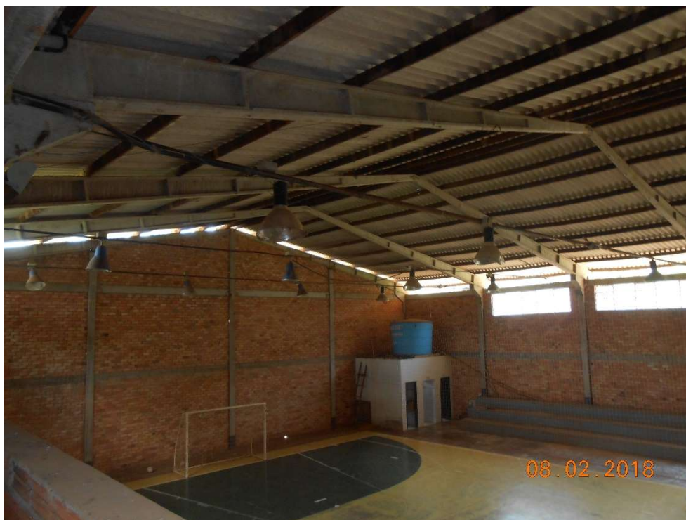
Figura 1 – Vista interna da edificação
