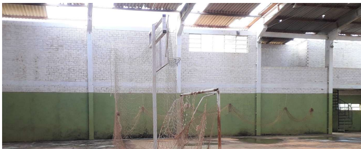
Figura 5 – Vista parede lateral
