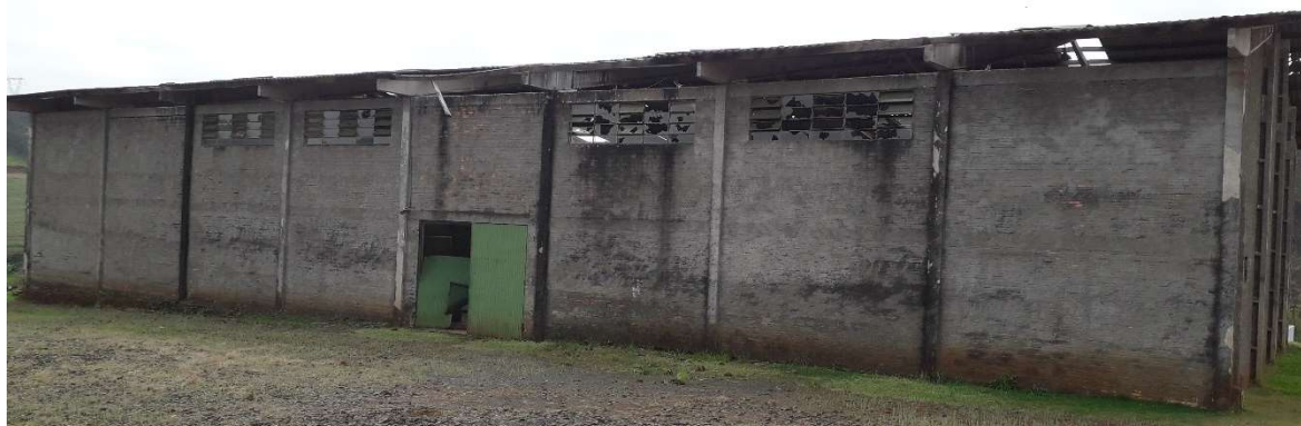
Figura 1 – Vista externa da edificação
