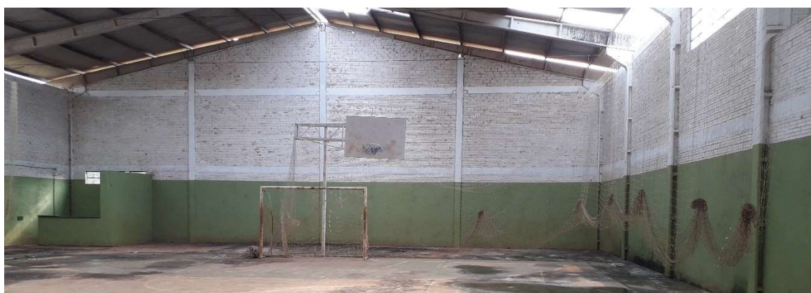
Figura 2 – Vista interna da edificação
