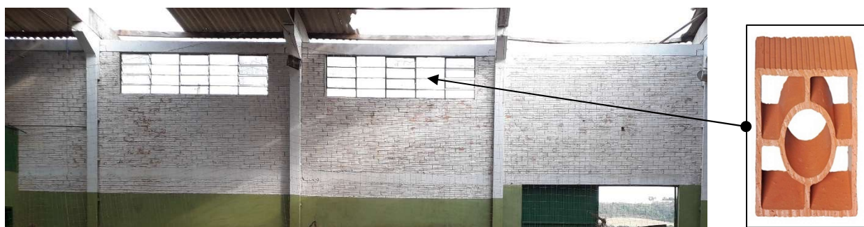
Figura 11 – Janelas a serem substituídas por tijolo cobogó
