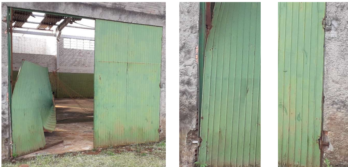
Figura 9 – Porta frontal – Chumbar os marcos na alvenaria
