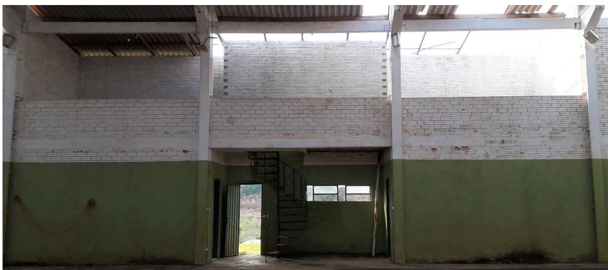
Figura 4 – Vista parede lateral
