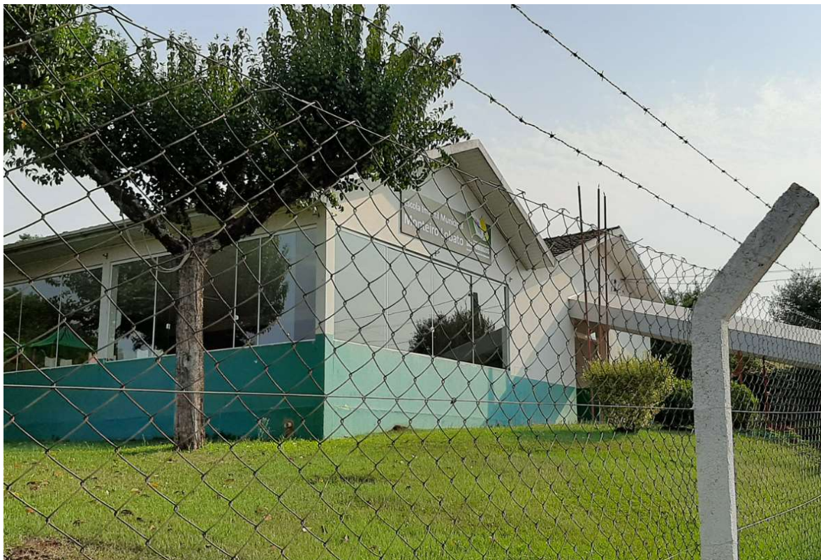
Figura 1 – Vista externa da edificação
